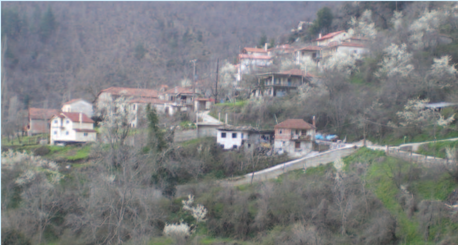
Η παράκαμψη με τα έργα υποδομής: τοίχιο αντιστήριξης.
