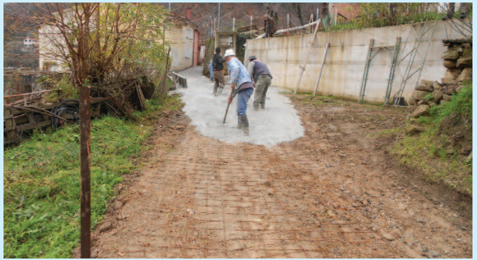
Οι εργασίες τσιμεντόστρωσης επί το έργον.
