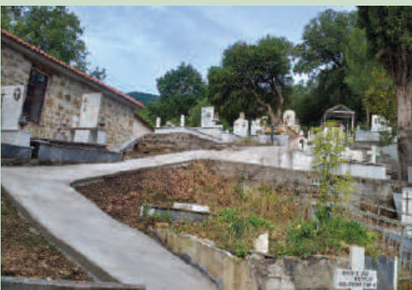
Τόσο περιμετρικά όσο και ενδιάμεσα – όπου αυτό ήταν εφικτό – έγιναν λειτουργικοί διάδρομοι και στηρίχτηκε αποτελεσματικά το κάτω μέρος προς τον δρόμο. Απομένει η τοποθέτηση του συρματινού πλέγματος.
