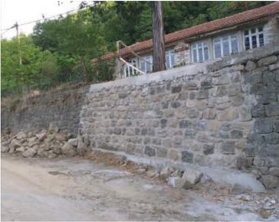
Η επισκευή της τοιχοποιίας του Σχολείου.
