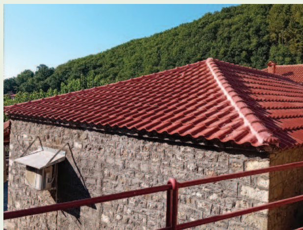
Η καινούργια στέγη του Μουσείου Λαϊκής Τέχνης με τις υδρορροές του.
